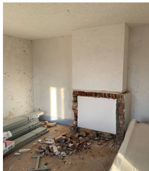
cheminée qui sera démontée
